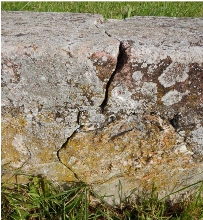
**Abbildung 10:** Aspekt der Mauer an der Straße „Am Reichsritterstift“ aus südwestlicher Richtung – Nahaufnahme der Fugen, vereinzelte Spalten vorhanden [Foto: BGNatur].
