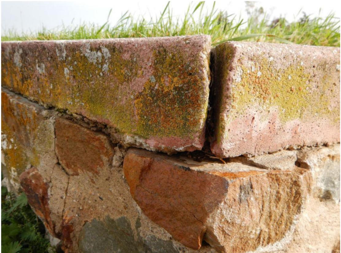
**Abbildung 11:** Aspekt der Mauer, die die Festwiese zur Straße „Am Reichsritterstift“ begrenzt, aus südwestlicher Richtung – Nahaufnahme der Fugen, vereinzelt Spalten vorhanden [Foto: BGNatur].
