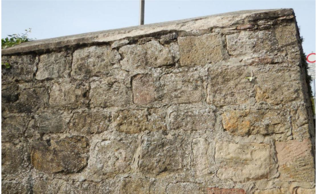
Abbildung 17: Aspekt der historischen Mauer, die das Untersuchungsgebiet im Süden begrenzt – Nahaufnahme der Fugen [Foto: BGNatur].
