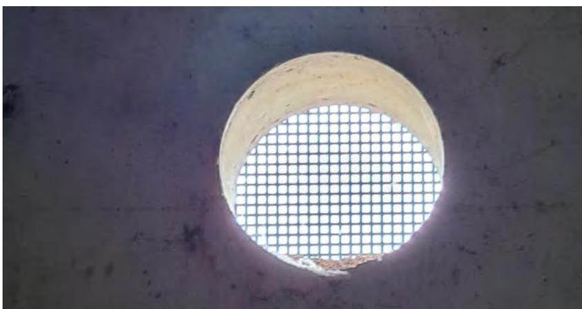
**Abbildung 31:** Aspekt Räumlichkeiten im Keller der Halle, Öffnungen nach außen engmaschig verschlossen [Foto: BGNatur].
