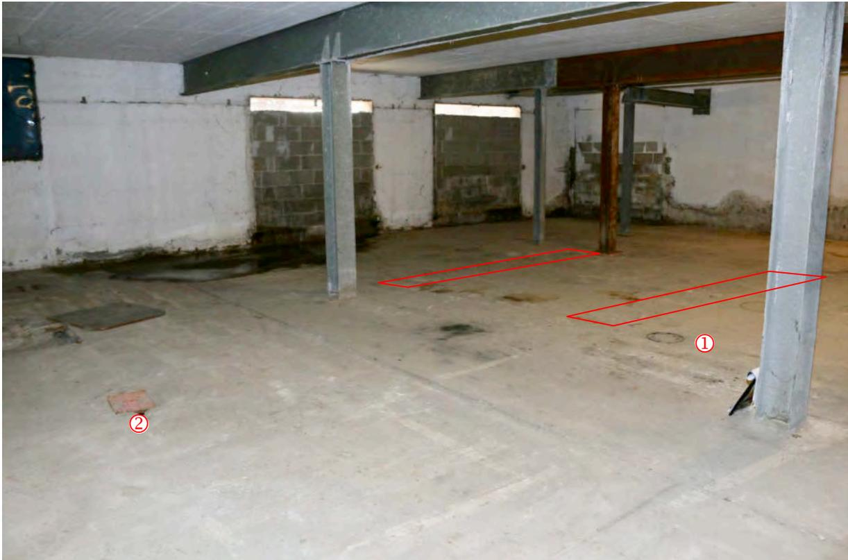
**Foto 10:** Blick nach Osten in den Tanklagerraum unter der ehem. neuen Glashütte. Im Boden sind alte Streifenfundamente erkennbar (rote Rahmen), auf dem Boden Abdrücke von Standfüßen ①. Links im Bild ein Benzinabscheider ②. Foto: M. Grimm 07.07.2021.
