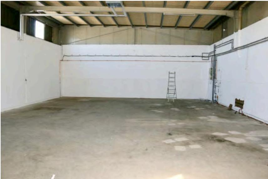
**Foto 6, links:** Blick von SW in die ehem. Dreherei. Der Boden ist z.T. ölfleckig. Foto M. Grimm 07.07.2020.
