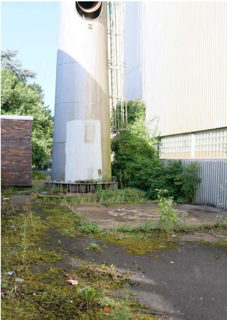
**Foto 4, links:** Blick auf den Unterteil des ehem. Kesselhausschornsteins, am Oberrand mit noch erkennbarer Öffnung der ehem. Rauchgaszuführung. Im Vordergrund Fundament mit Abdruck des ehem. Glaswerk-Schornsteins. Das Backsteingebäude links im Bild ist die ehem. Notstromstation, zuletzt Traforaum und Stromversorgung. Foto M. Grimm 07.07.2020.
