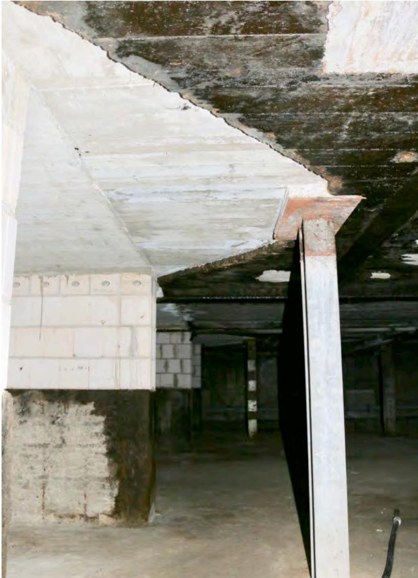
**Foto 8, links:** Blick nach SE in den Kriechkeller unter der ehem. alten Glashütte. Anhand der verschlossenen alten Deckdurchbrüche und den alten Fundamenten ist die Lage der beiden alten Glasöfen (jeweils links der beiden Metallstützen) gut erkennbar. Die alten Deckenbereiche und Fundamente sind stark versottet und verharzt (dunkle Verfärbung). Foto: M. Grimm 07.07.2021.
