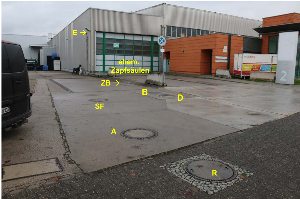
Abb. 6: Blick von Westen auf die stillgelegte Tankstelle der Fa. Kuemmerling. Vor dem Bereich der ehem. Neuen Zapfsäuleninsel der zentrale Befüllschacht (ZB). Schräg davor die Domschächte des Zweikammer-Erdtanks (B = Benzin, D = Diesel). Im Vordergrund das Abscheidersystem bestehend aus Schlammfang (SF), Abscheider (A) und Revisionschacht (R). Im Hintergrund an der Halle die Entlüftungsleitungen (E).
