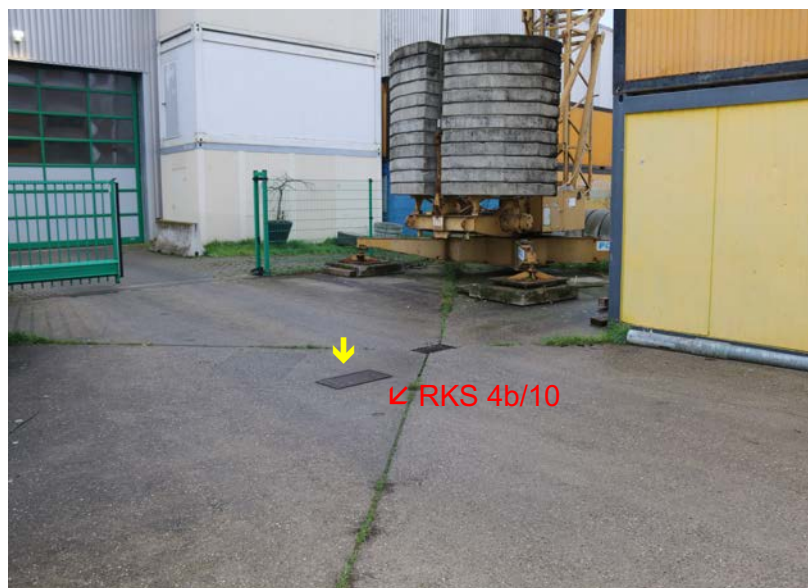
Abb. 4: Blick von S auf den ehem. Waschplatz. Im Zentrum der alte Abscheider (gelber Pfeil), davor der Bohransatzpunkt RKS 4b/10 (siehe Anlage 6).
