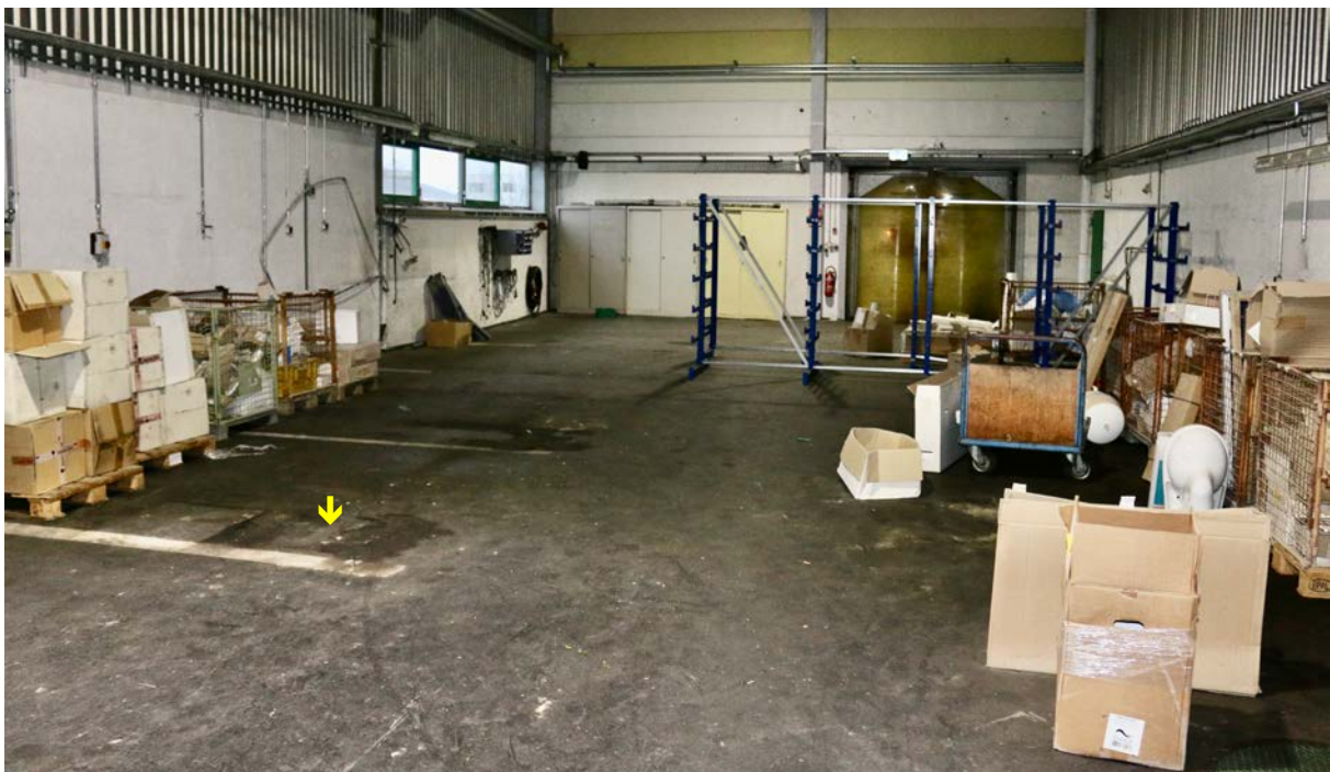
Abb. 3: Blick in die ehem. Kapselstanzerei bzw. ehem. Instandhaltungswerkstatt. Der Boden ist z.T. fleckig verölt (gelber Pfeil).
