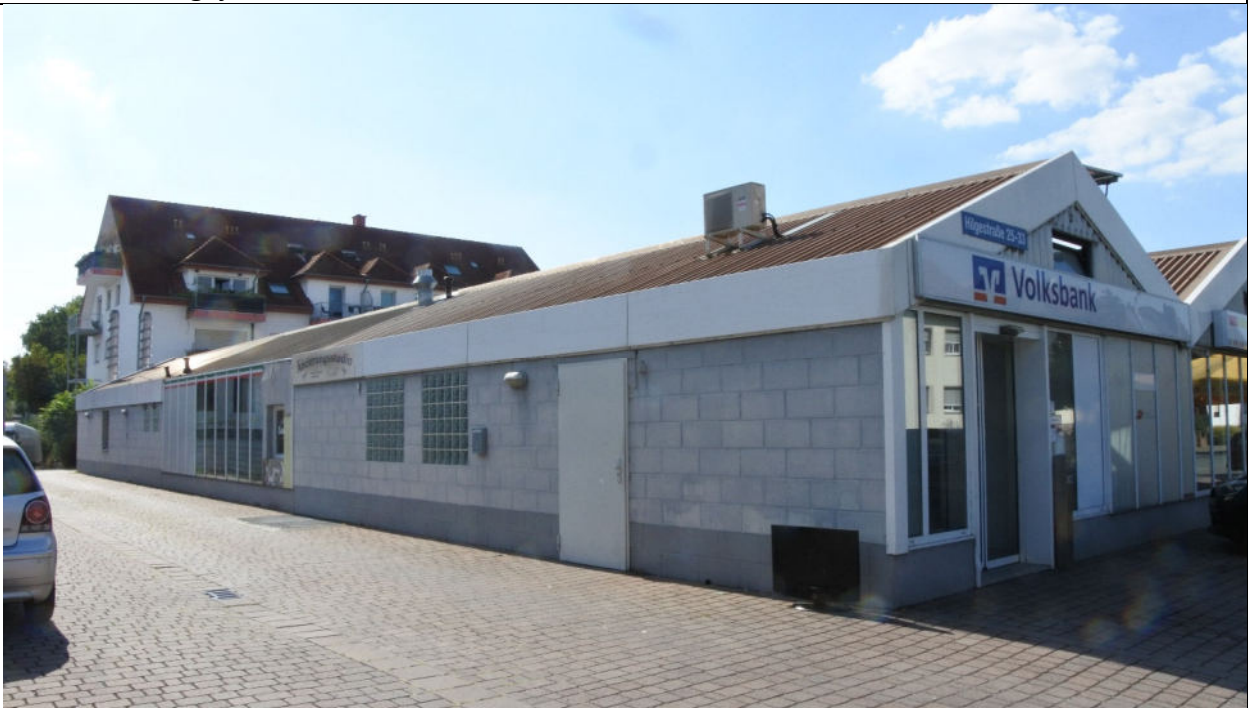
Abbildung 2: Süd- und Teile der Ostfassade des Gebäudekomplexes Hilgestr. 25-33, Bodenheim. (Foto: BG Natur)
