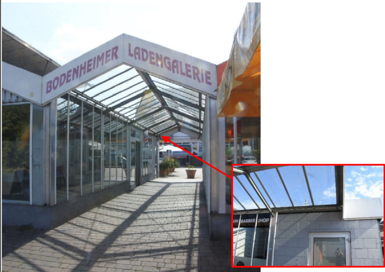
Abbildung 4: Ansicht des Glasüberbaus zwischen den Geschäften (Bild oben). Detail des Glasüberbaus (Bild unten) ohne Hinweise auf Nutzung durch Gebäudebrüter oder Fledermäuse. (Fotos: BG Natur)
