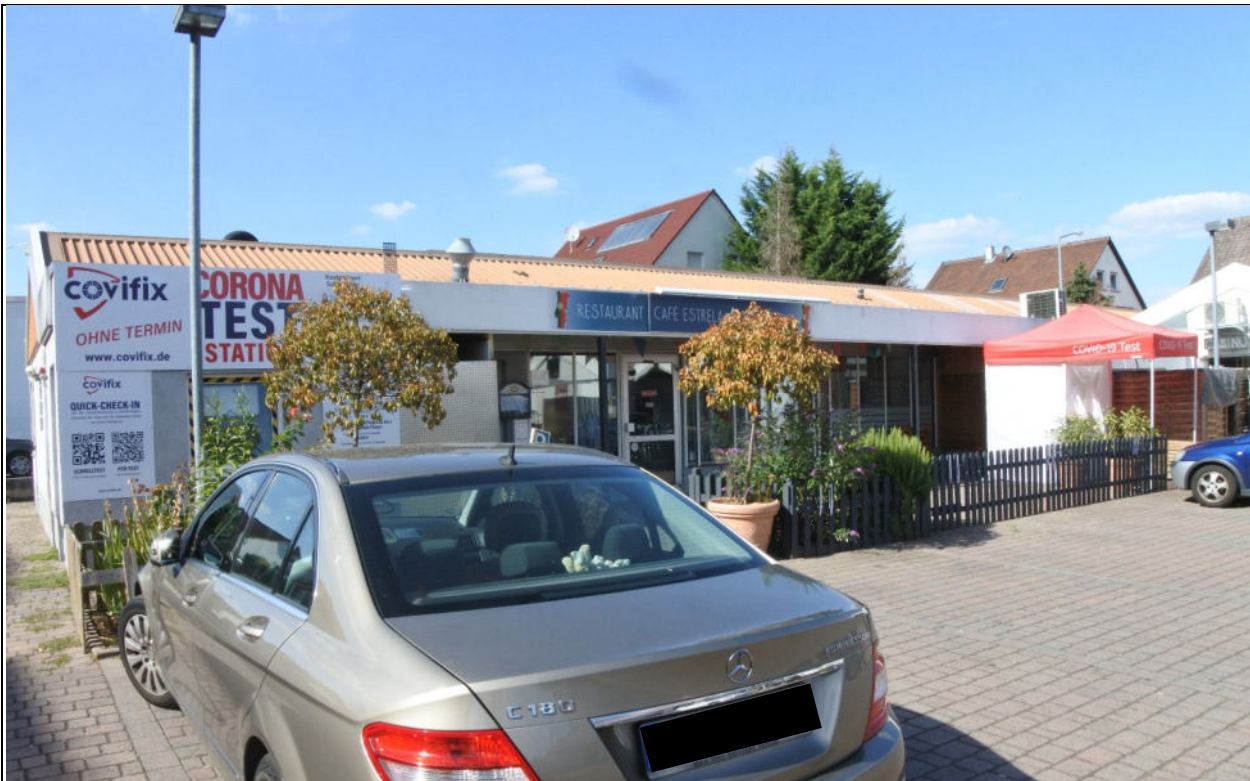
Abbildung 9: Blick auf nordwestlichen Gebäudeteil (Bild oben). (Fotos: BG Natur)
