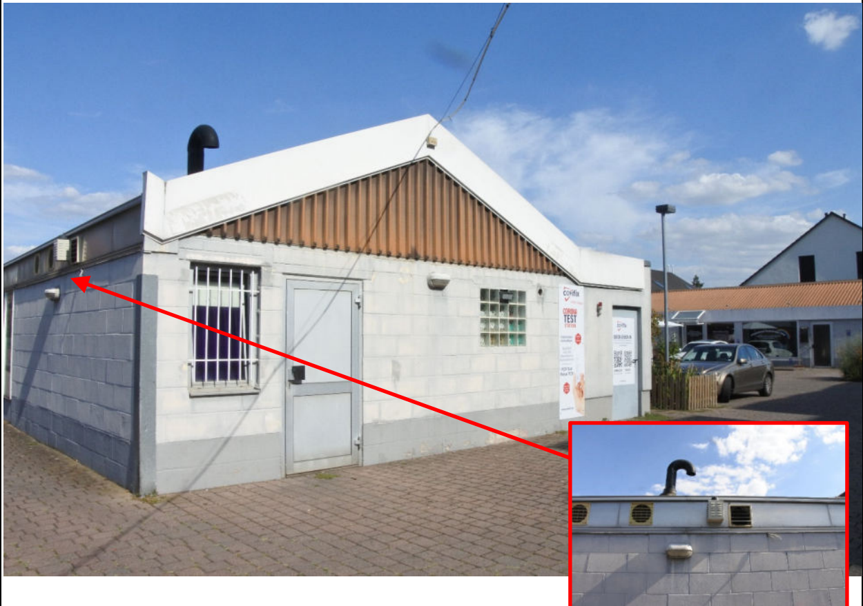
Abbildung 8: Blick auf südwestlichen Gebäudeteil (Bild oben). Detail des südwestlichen Gebäudeteils Richtung Parkplatz im Innenhof (Bild unten). Durch Lüftungslamellen ist kein Einschluß von Tieren möglich, da dieser innen engmaschig vergittert ist. (Fotos: BG Natur)
