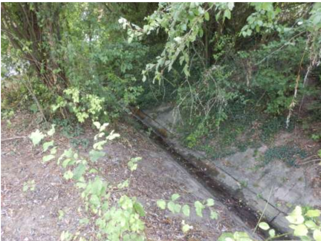
Bild 04: Der nördlich begrenzende Kappelgraben
