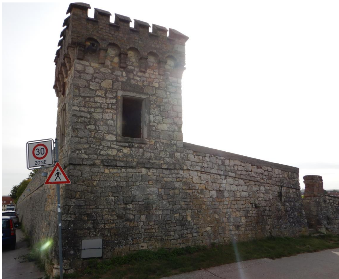
Abbildung 18: Aspekt der historischen Mauer, hier mit Turm, die das Untersuchungsgebiet im Süden begrenzt aus westlicher Richtung [Foto: BGNatur].
