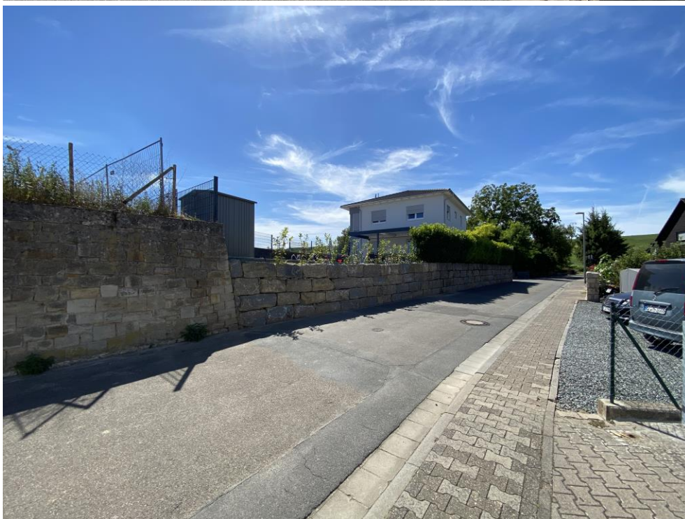
Blick nach Nordwesten in Burgweg (Quelle: Eigene Aufnahmen, 12.07.2022)
