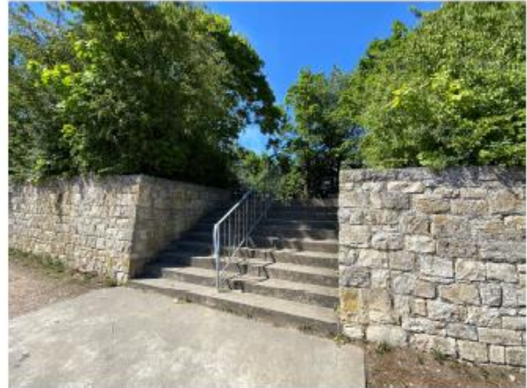
Zugang zum Grillplatz über Treppenanlage, Aufnahme von Süden
