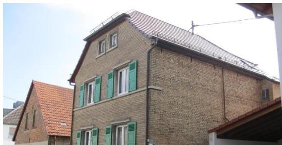
Krüppelwalmdach aus Tonziegeln in der Ölsmühlstraße
