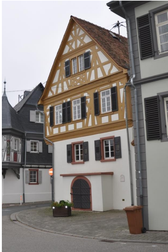
Regenfallrohre aus Zinnblech an historischen Gebäuden des alten Ortskerns (Mainzer-Pfort-Straße)
