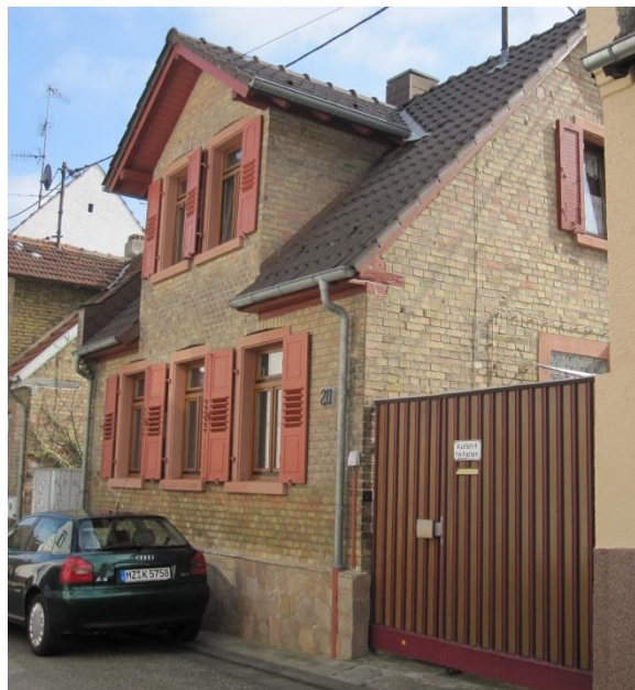
Die Klappläden an den Fenstern ergeben ein durchgehendes Band (vgl. Abschnitt Klappläden); Neugasse
