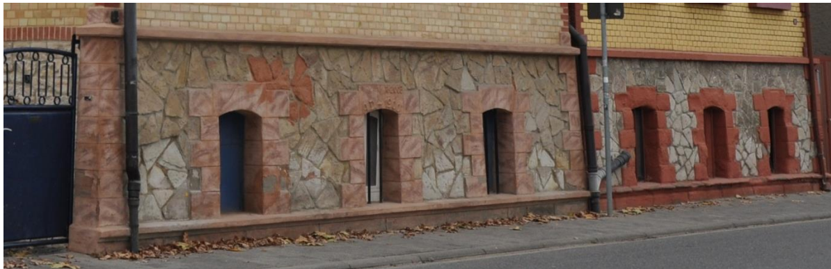
Ausgestalteter Sockel in der Wormser Straße; deutlich vom Rest der Fassade abgrenzbar
