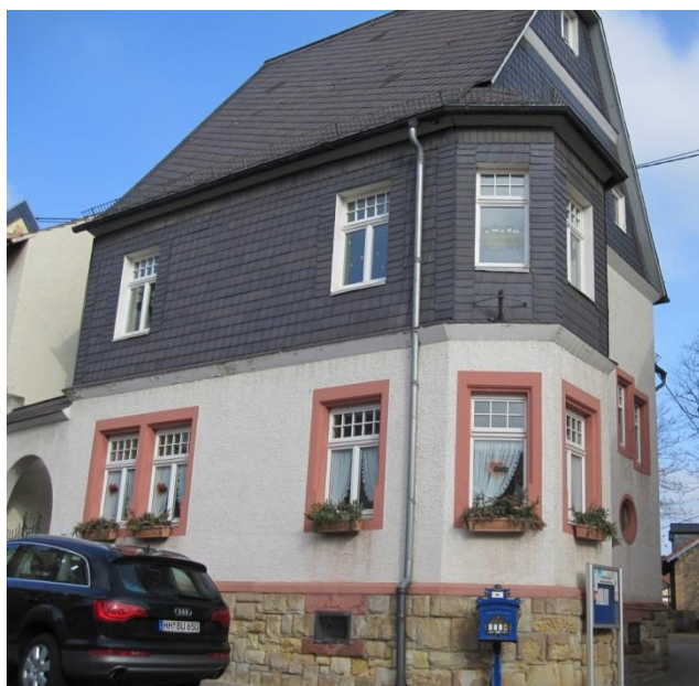
Stehende, zweiflügelige Fenster mit Oberlicht in der Rathausstraße
