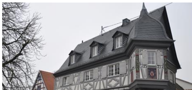
Satteldach aus Schiefer in der Mainzer-Pfort-Straße
