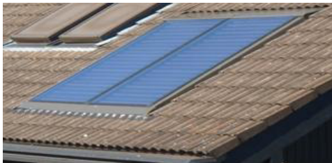
Sonnenkollektoren in .....und auf der Dachhaut
