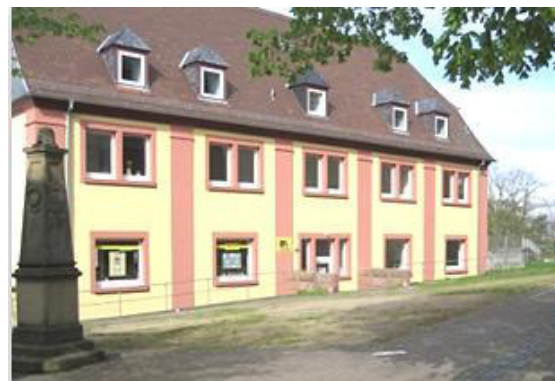
Putz- und Sandsteinfassade
