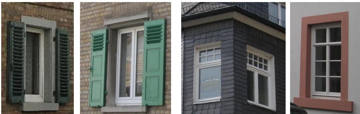
Stehendes Fensterformat, zweiflügeliges Fenster, zweiflügeliges Fenster mit Oberlicht, Sprossenfenster
