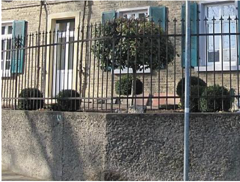
Stabzaun aus Schmiedeeisen auf Mauer
