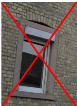
Rollladenkästen sind innenliegend, d.h. nicht vom Straßenraum aus sichtbar, anzubringen
