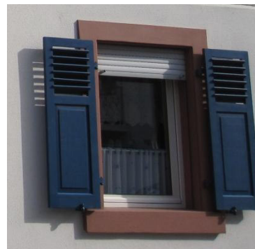
Rollladenkästen sind innenliegend, d.h. nicht vom Straßenraum aus sichtbar, anzubringen
