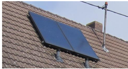
Sonnenkollektoren in .....und auf der Dachhaut
