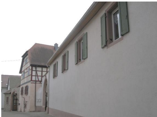
Putz- und Fachwerkfassaden
