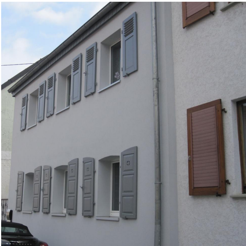
Fassade mit energetischer Wärmedämmung
