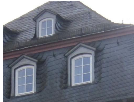
Naturrote bis rotbraune Dacheindeckungen und .....Schiefereindeckung am Mansarddach
