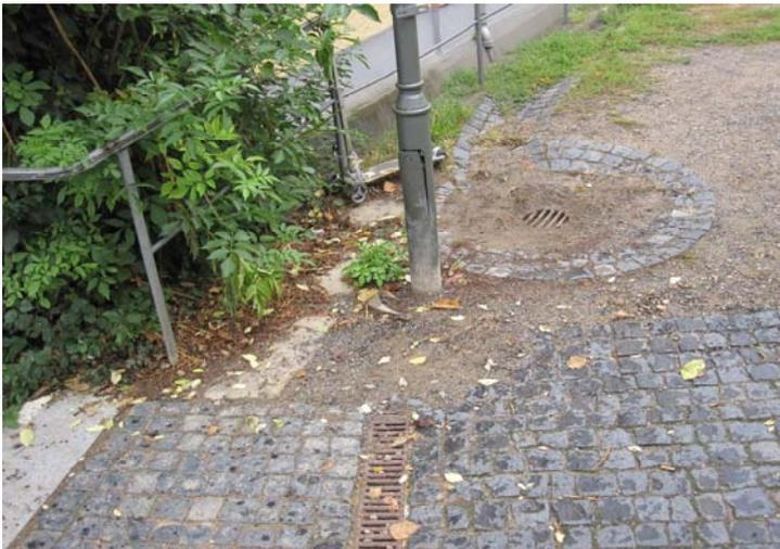
**Bild: Die Oberflächenentwässerung des Kirchenplatzes ist derzeit unzureichend...**
