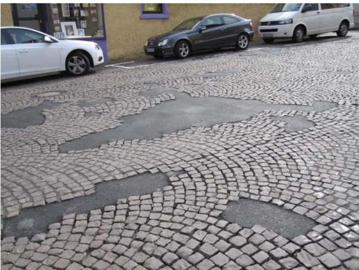
**Bild: erhebliche Schäden im Belag / Unterbau des Rathausplatzes**
