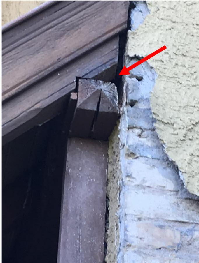
**Abbildung 10: Detail der Holzverkleidung des Vordachs über der Eingangstür, der rote Pfeil weist auf eine Einschlupfmöglichkeit.**
