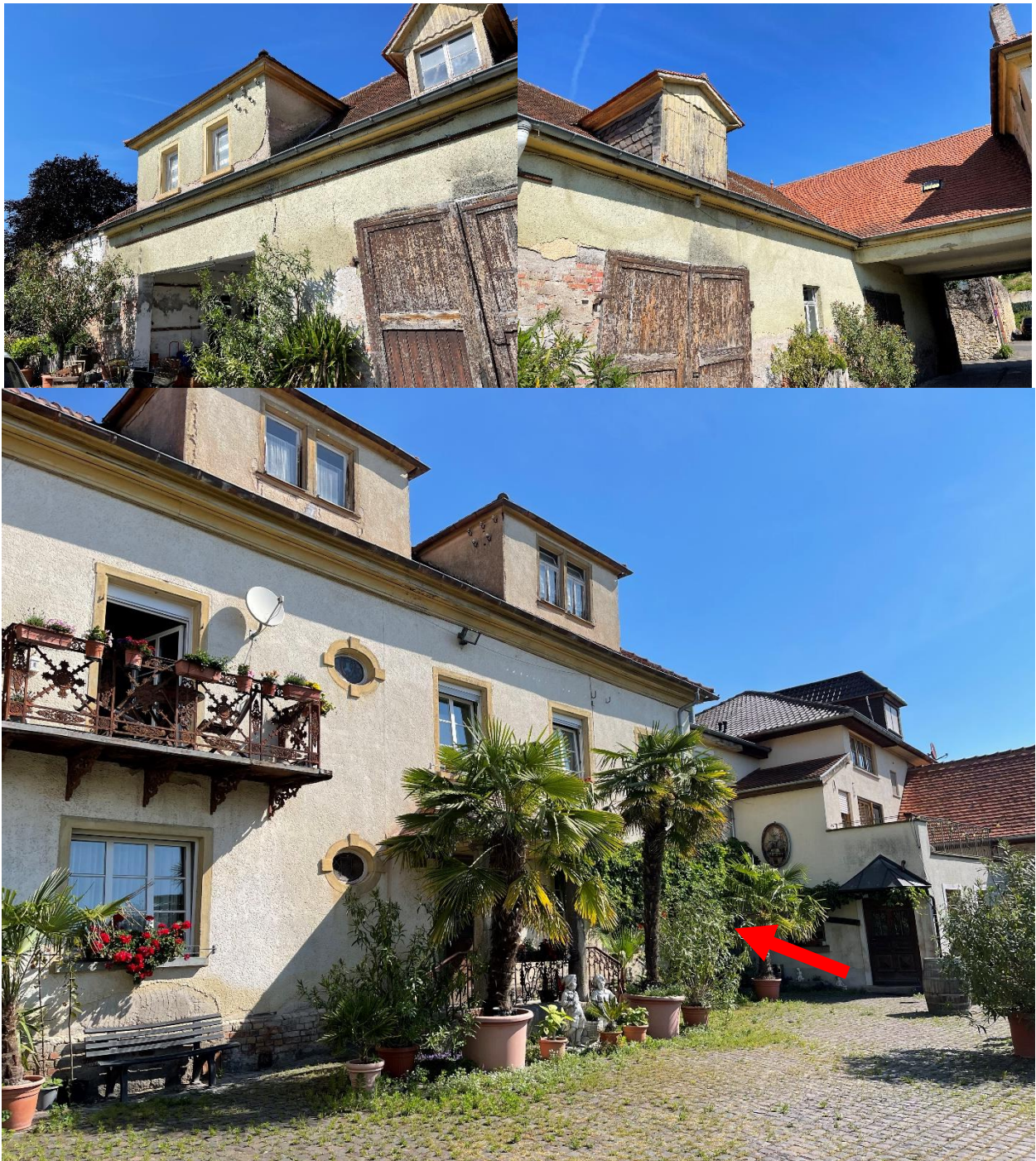
Abbildung 3: Ansichten der Gebäude mit der Hauptdurchfahrt (oben rechts) und der Durchfahrt mit 3 Rauchschnalwellennestern (unten roter Pfeil) [Fotos: BGNatur].
