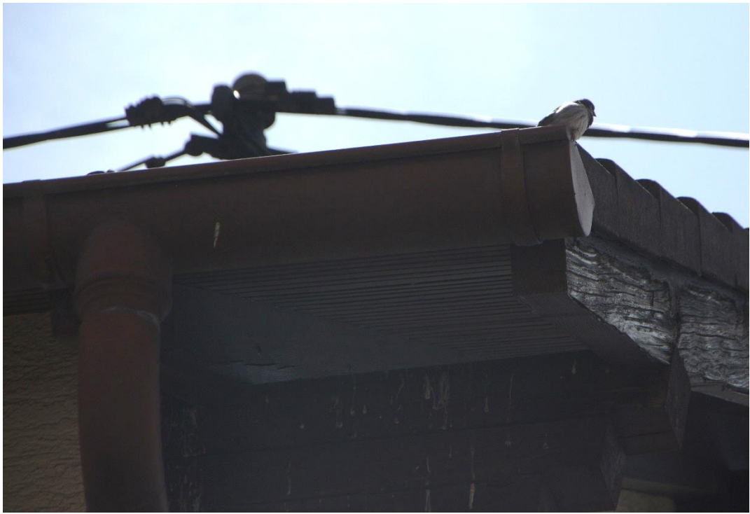
Abbildung 32: Haussperling Passer domesticus auf Gebäude Rheinstraße 17 aus nordöstlicher Richtung; am Balken darunter sind deutlich Kotspuren zu sehen, was auf eine Besiedlung durch Gebäudebrüter hinweist (Fotos: BGNatur).
