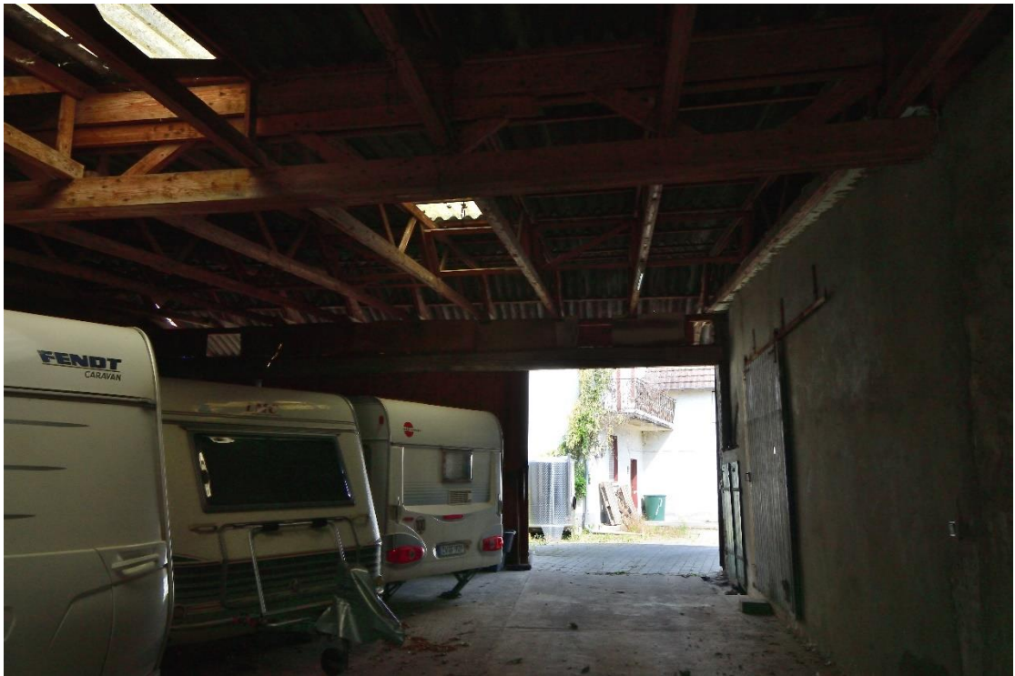
Abbildung 6: Östliche Scheune im Norden von Flurstück 157/4 (Fotos: BGNatur).
