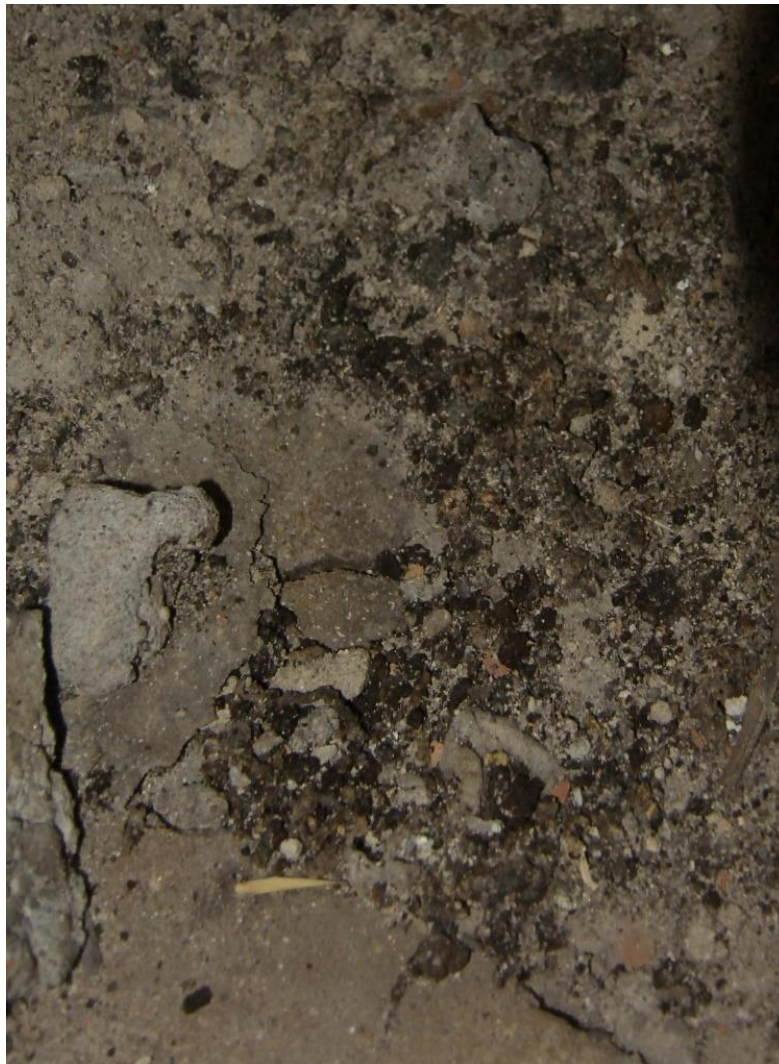
Abbildung 34: Fledermauskot auf dem Dachboden des Wohnhauses.
