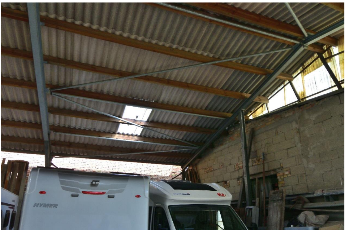
Abbildung 7: Westliche Scheune im Norden von Flurstück 157/4 (Fotos: BGNatur).
