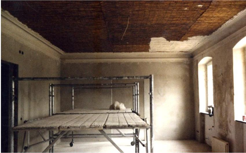
Auf die Holzbalkendecke werden Putzträger aus Rohrmattengewebe genagelt.
