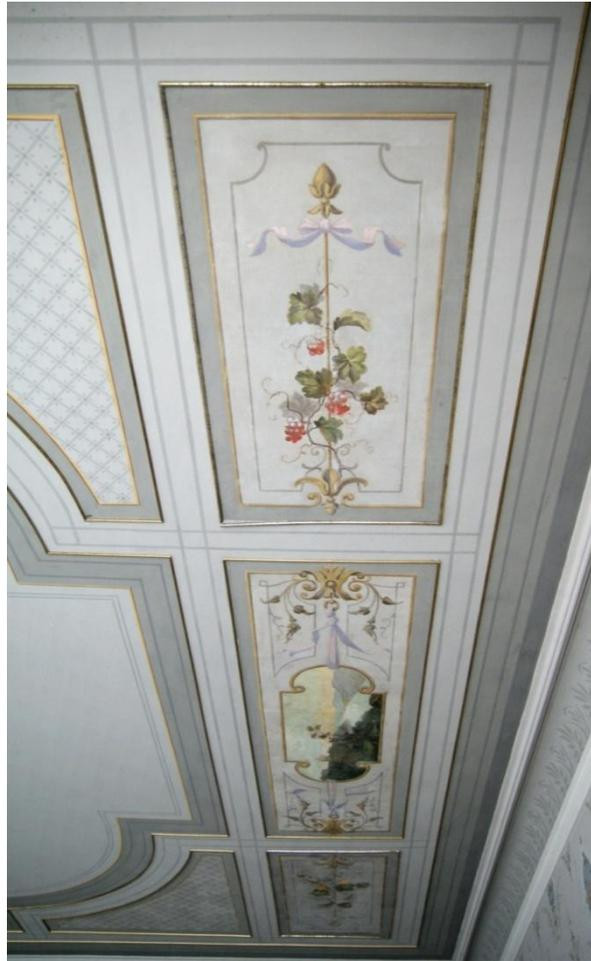
Die originalen, vergoldeten Profilstäbe werden nach Originalbefund angebracht und ergänzt.
