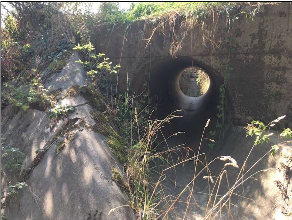
Abbildung 5: Durchlass Entwässerungsgraben B5
