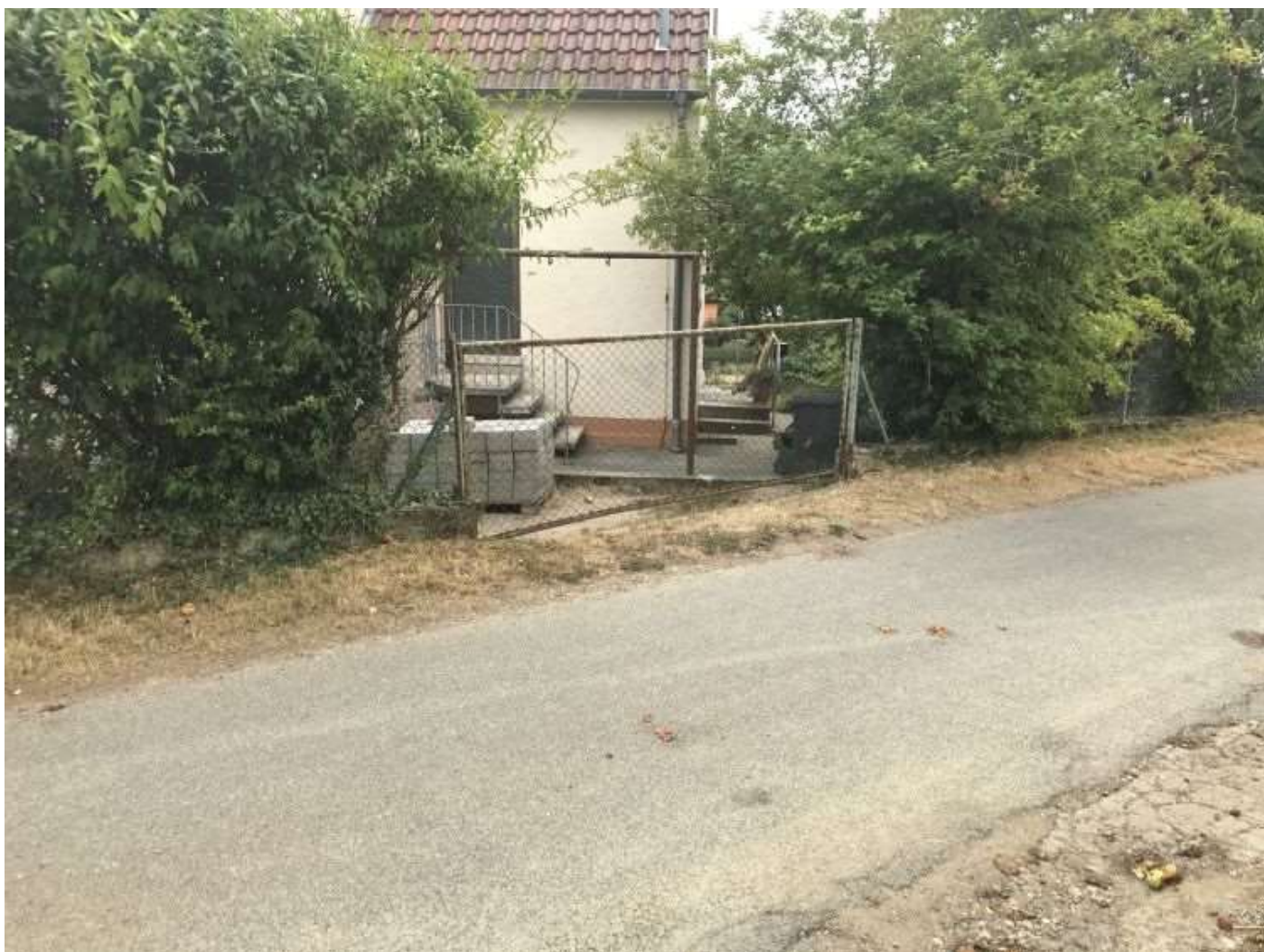
Abbildung 1: Von Hangwasser gefährdetes Haus in der Bahnhofstraße
