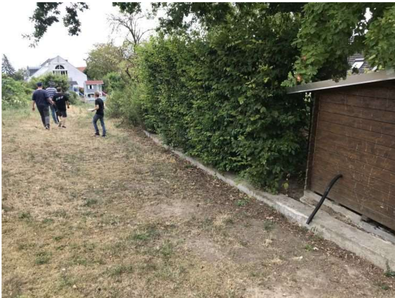
Abbildung 3: Zu niedrige Mauer an der Hangseite an einem Grundstück in der Bahnhofstraße
