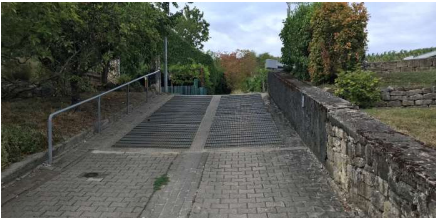
Abbildung 7: Einlaufbauwerk in der Weinbergstraße
