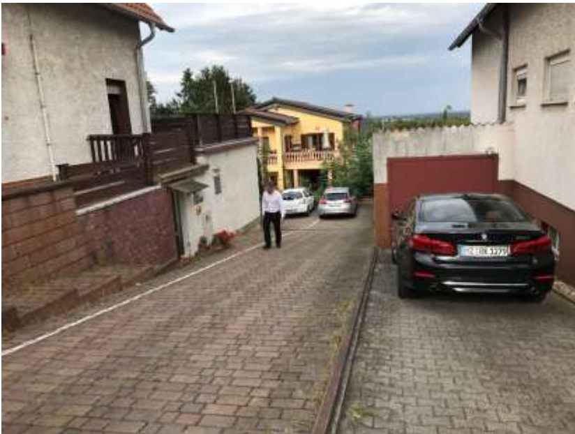
Abbildung 13: Überflutungsgefährdete Einfahrt in der Lörzweiler Straße
