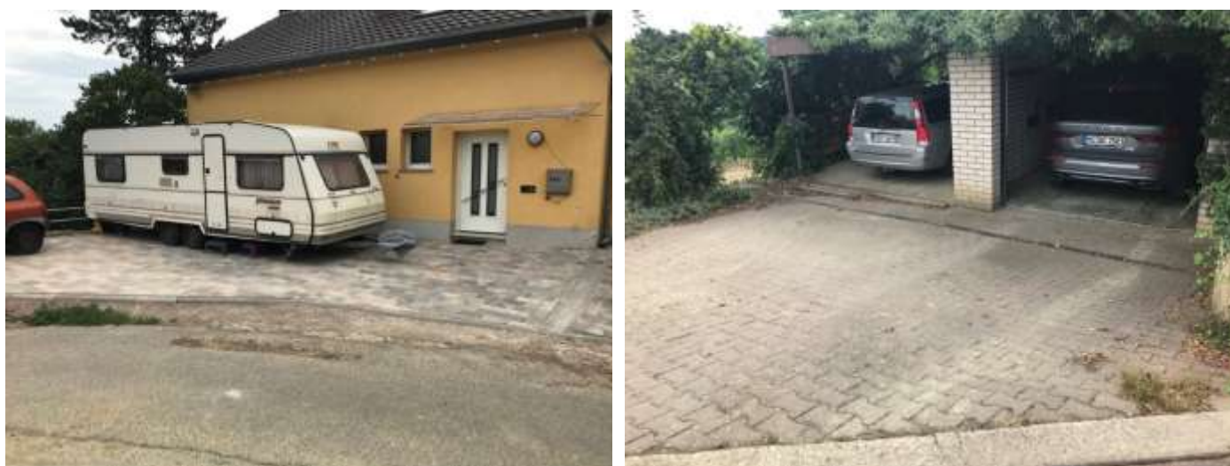
Abbildung 2: Haus mit überflutungsgefährdeter Eingangstür (links) und Garage (rechts)
