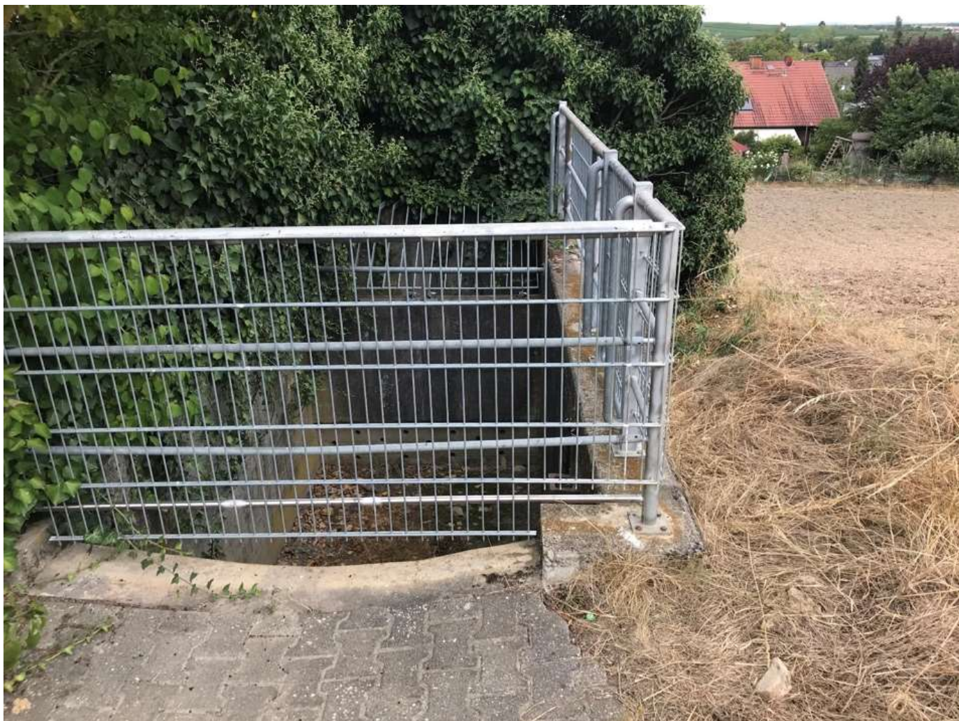
Abbildung 11: Einlaufbauwerk oberhalb des Portugieserwegs
