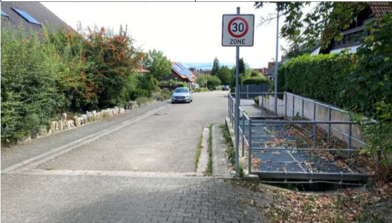
Abbildung 1: Schlammfang in der Straße „Am Börnchen“
