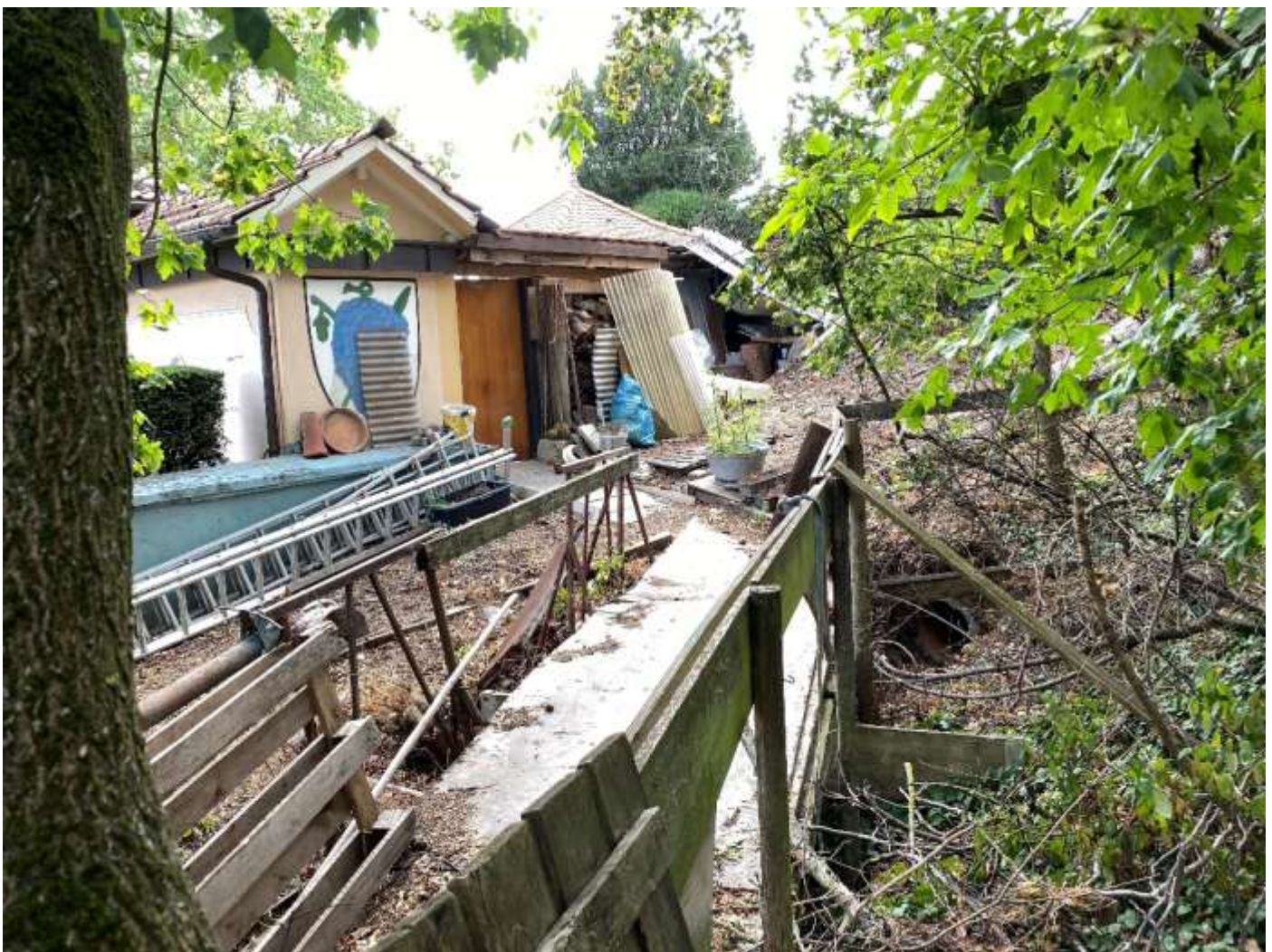
Abbildung 5: Grundstück Nr. 1 in der Straße "Am Weinberg"
