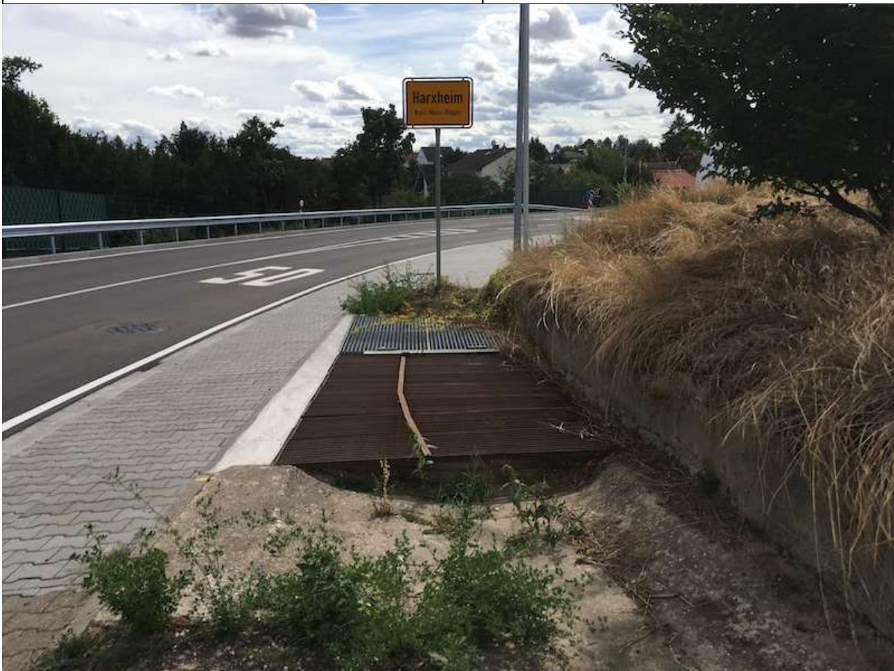
Abbildung 6: Einlaufbauwerk am Ortseingang in der Gaustraße
