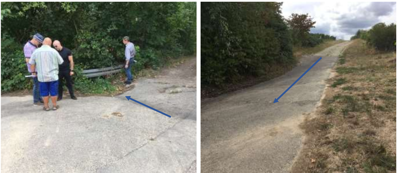
Abbildung 10: Einlaufmulde in Graben und Regenrückhaltebecken
