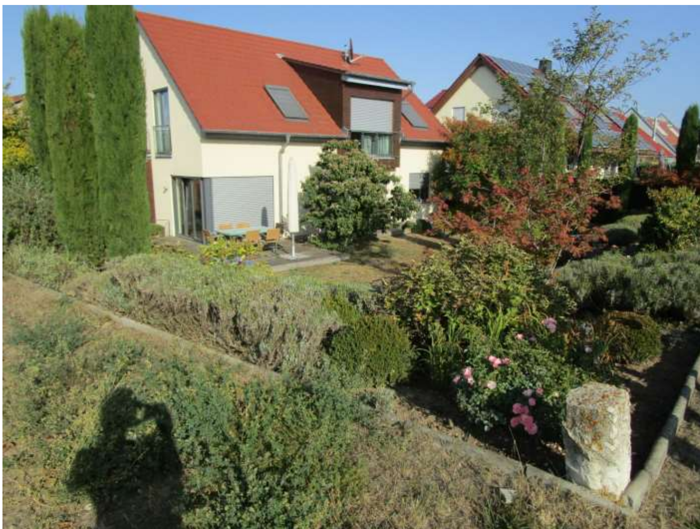
Abbildung 6: Ungeschütztes Gebäude in der Alemannenstraße
