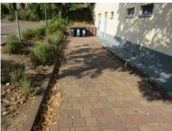
Abbildung 3: Ungeschützte Eingänge in die CKarl-Zuckmayer-Halle
