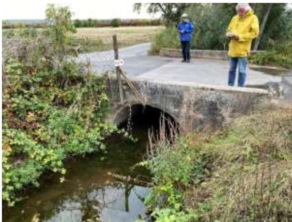
Abbildung 8: Prüfen ob Vergrößerung des Durchlasses möglich ist
