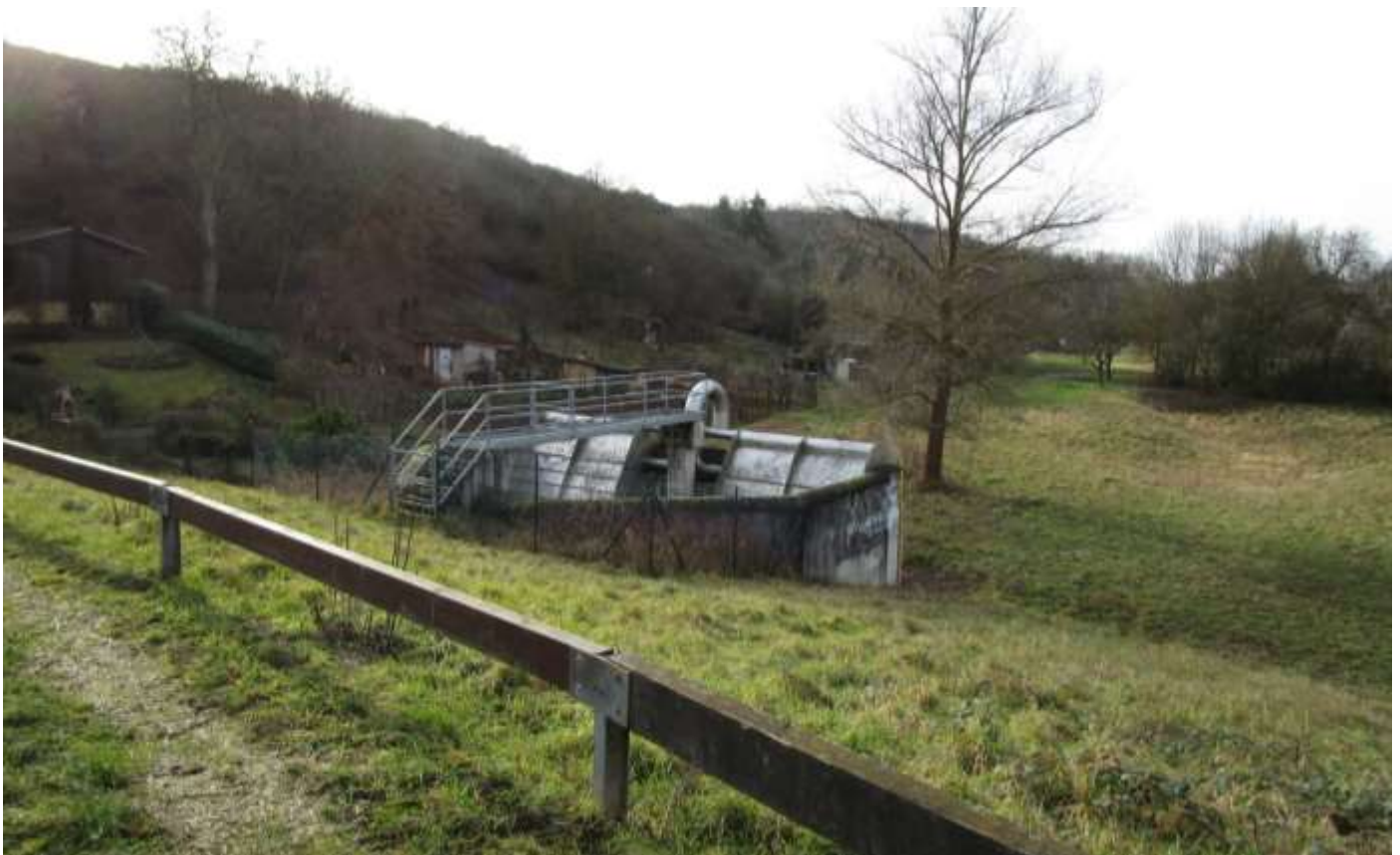
Abbildung 7: Hochwasserentlastung des Rückhaltebeckens am Eichelsbach 231214-790_Nackenheim_Manuskript_nachBIV.docx
